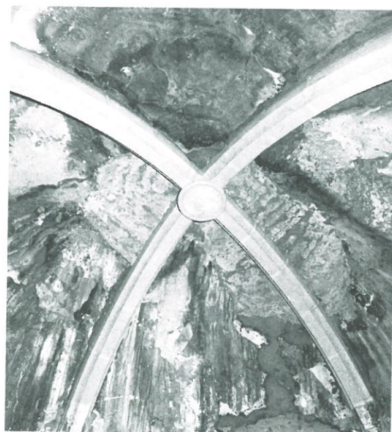
Figura 27. Bóveda de la torre circular, con nervadura en aspa y botón central, tras su restitución.
