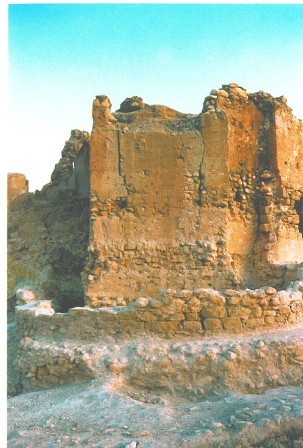
Figura 24. Torre almohade de tapial transformada en circular con revestimiento de sillares de época condal.
