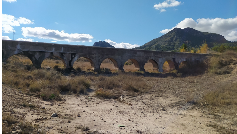
Acueducto existente en el ámbito
