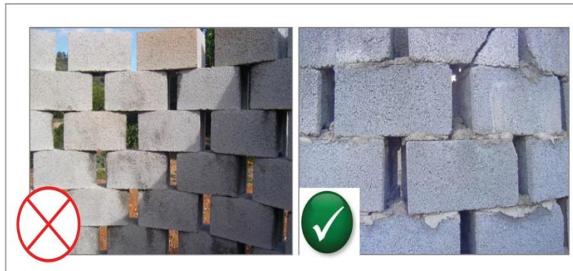
Foto 2. Construcción formada por bloques con y sin cemento de unión.
