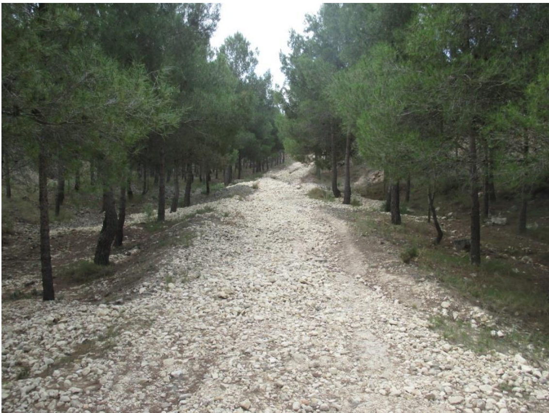
IMAGEN 7. CAMINO SUBIDA MONTE DE LA LOBERA, TRAMO DAÑADO POR LLUVIAS. VIAL CRE-VI-3.046.01
