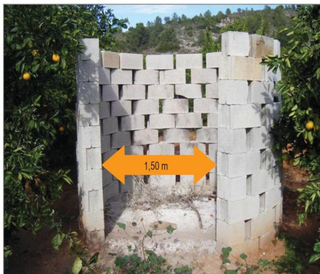
Foto 1. Abertura lateral o boca de alimentación de un quemador agrícola.
