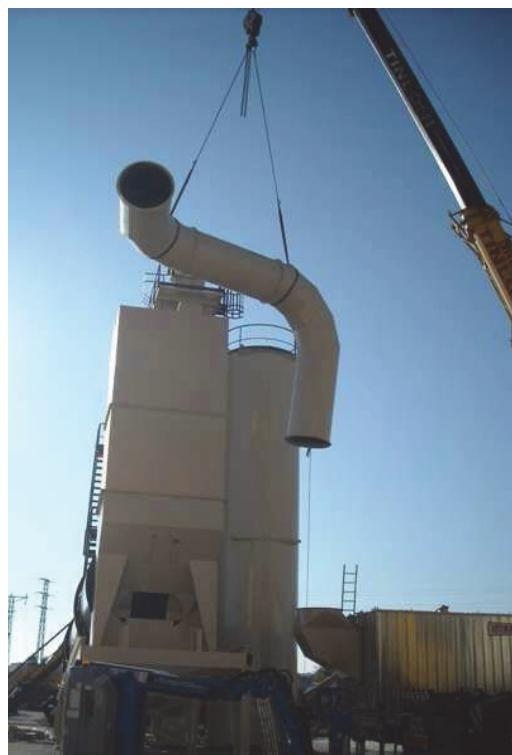
**ATENCIÓN:** este conducto debido a su forma, peso y dimensiones puede bascular considerablemente al ser levantado con las cadenas por lo que es necesario guardar una distancia mínima de seguridad de 4 o 5 metros durante esta operación. El supervisor de montaje se encargará de guiar la maniobra y vigilar que se respete dicha distancia de seguridad y nadie pase por debajo ni por las inmediaciones de la carga.
