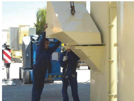
Es aconsejable después de haber presentado el recibidor de elevador, probar que todos los tornillos pasan bien por los agujeros para evitar pérdidas de tiempo al meterlo y luego al tratar de desmontarlos por posibles residuos de pintura en las uniones. Montar lona de unión pico elevador by-pass.
