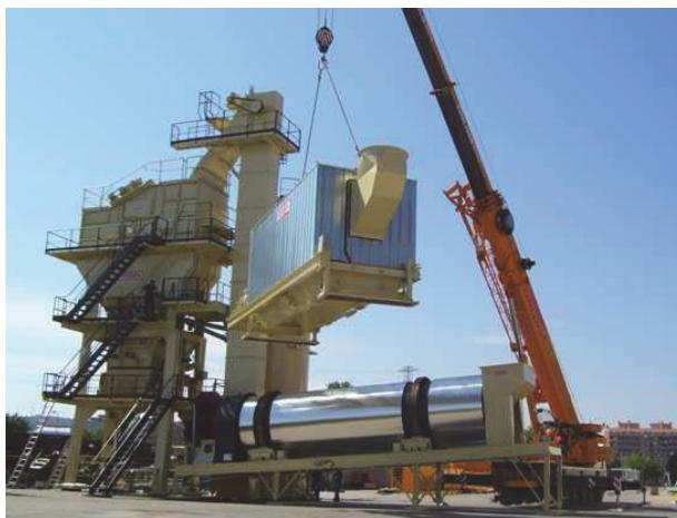
Si el filtro de mangas es rodado, se posicionará con ayuda de la cabeza tractora y se elevarán las patas Jost hasta su posición de trabajo. Si lleva placas de anclaje a las que soldar las patas del filtro se empleará peto, polainas, mascarilla FFT2 y la máscara de soldador con cristal actínico según norma UNE EN169 y EN166
